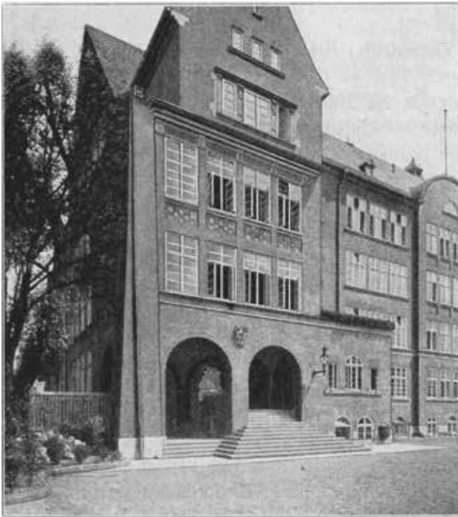
Abb. 209. Volksschule Telemannstraße, Ansicht.
