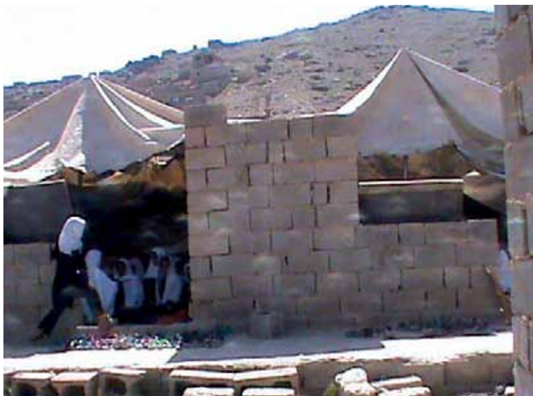
800 Kinder tagtäglich, die in dieser Feldschule unterrichtet werden.
