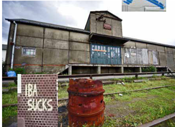
Ehemalige Industriehalle in Wilhelmsburg: Drehort des Erfolgsfilms, zuletzt Tanzhalle
