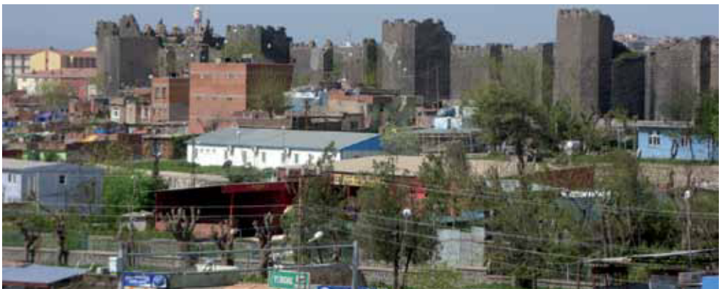
Die antike Stadtmauer von Diyarbakir ist durch die Kämpfe bedroht
